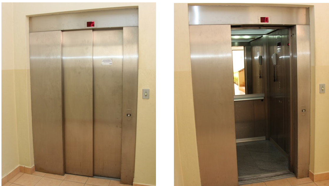
Elevadores de acesso aos pisos superiores
