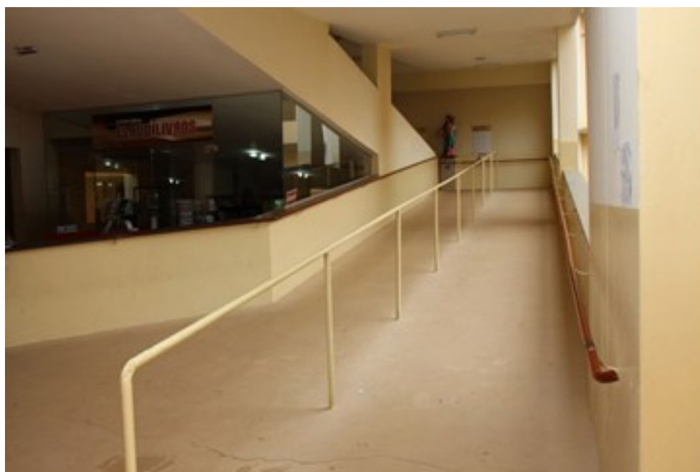
Rampa de acesso ao piso superior
