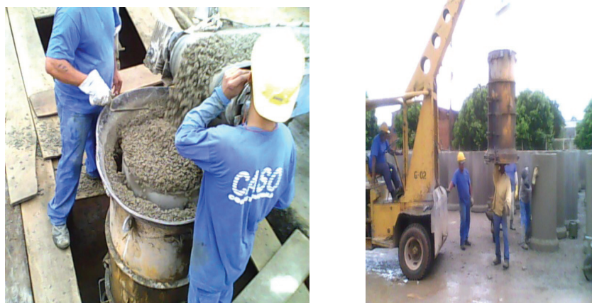
Figura V – Núcleo vibratório e tubo desmoldado (Fonte: Queiroz - 2012)
