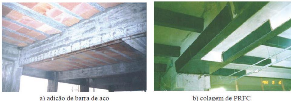
**Figura II:** Aplicação da técnica EBR com utilização de barras de aço e fibras de carbono (FERRARI, 2007).
