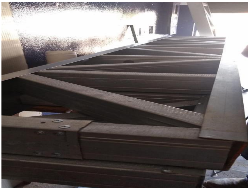
Figura 3: Trelça 1 executada com perfis de Light Steel Frame.
