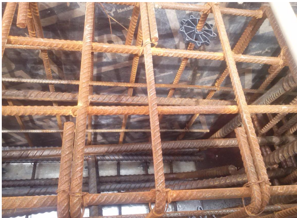
Figura 6 – Verificação do cobrimento de armadura.
