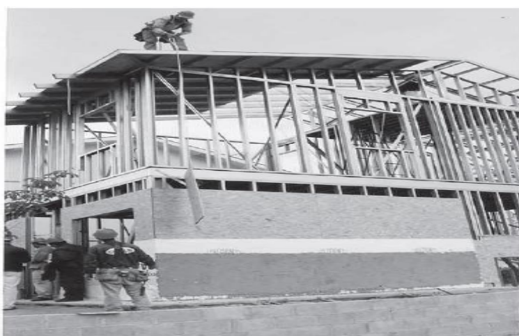
Figura 2 - Treliças metálicas revestidas em OSB . Fonte: Freitas; Crasto (2006).
