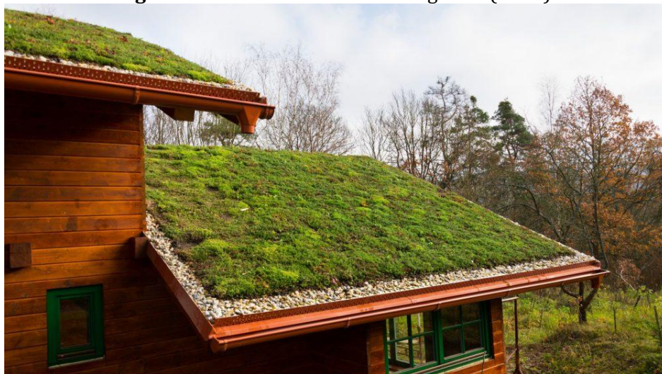
Figura 1 - Telhado verde. Fonte: Bigstock (2018).
