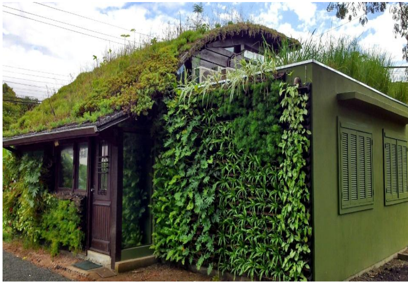
Figura 3 - Telhado verde. Fonte: EcoTelhado (2018).
