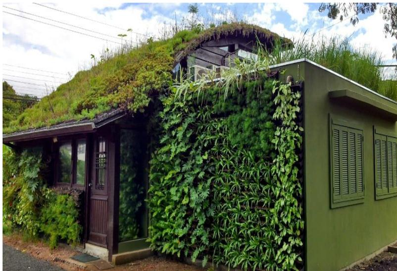
**Figura 3** - Telhado verde. Fonte: EcoTelhado (2018).
