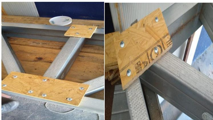
**Figura 5 a e b:** Disposição das placas *OSB* na treliça 3.
