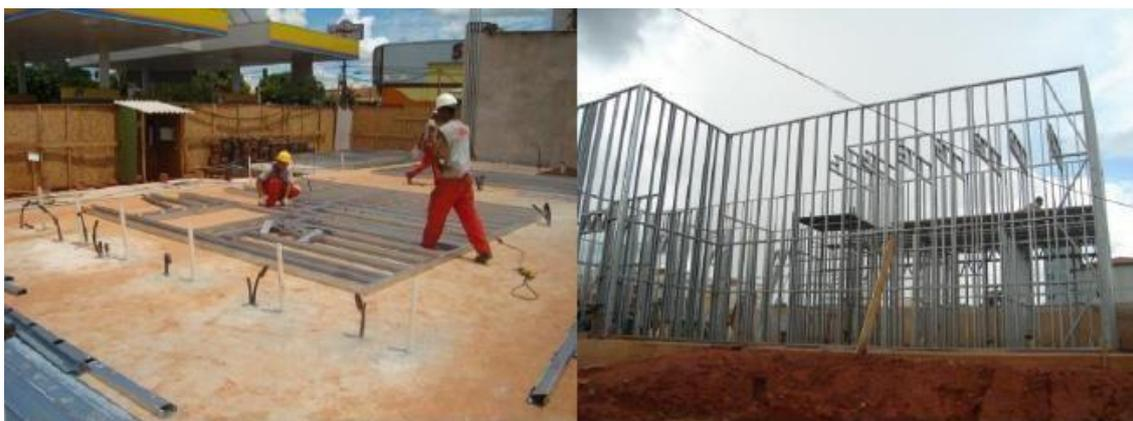
**Figura 1** - Montagem de painéis em estrutura metálica. **Fonte:** Campos (2014).
