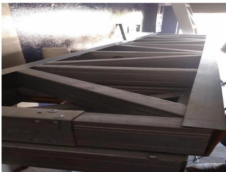
**Figura 3:** Treliça 1 executada com perfis de *Light Steel Frame*.
