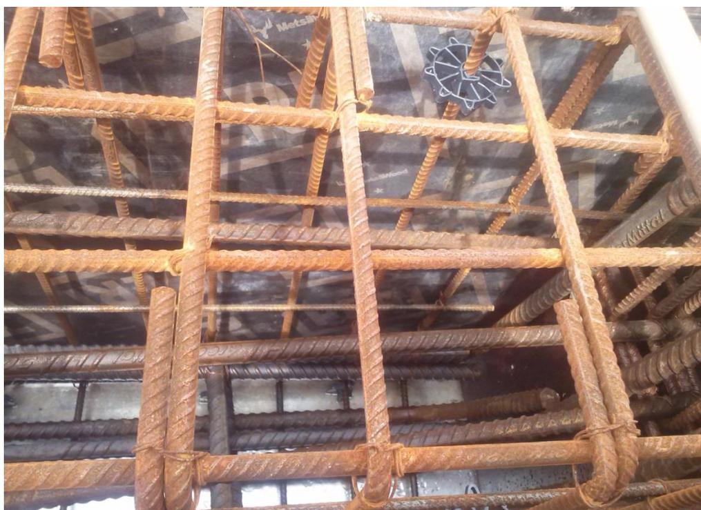
Figura 6 – Verificação do cobrimento de armadura. Fonte: Autor (2018).
