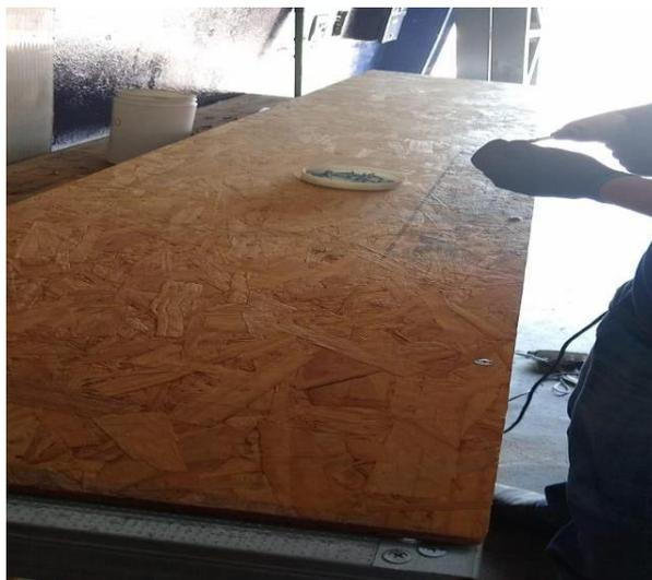
**Figura 4:** Revestimento das faces da treliça 2, utilizando *OSB*.
