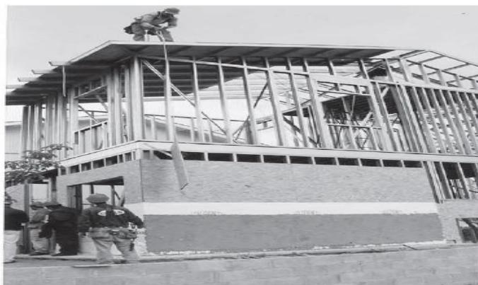
**Figura 2** - Treliças metálicas revestidas em OSB. **Fonte:** Freitas; Crasto (2006).
