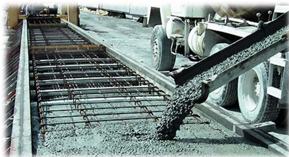
Figura 1 - Lançamento do concreto autoadensável. Fonte: BASF (2013).
