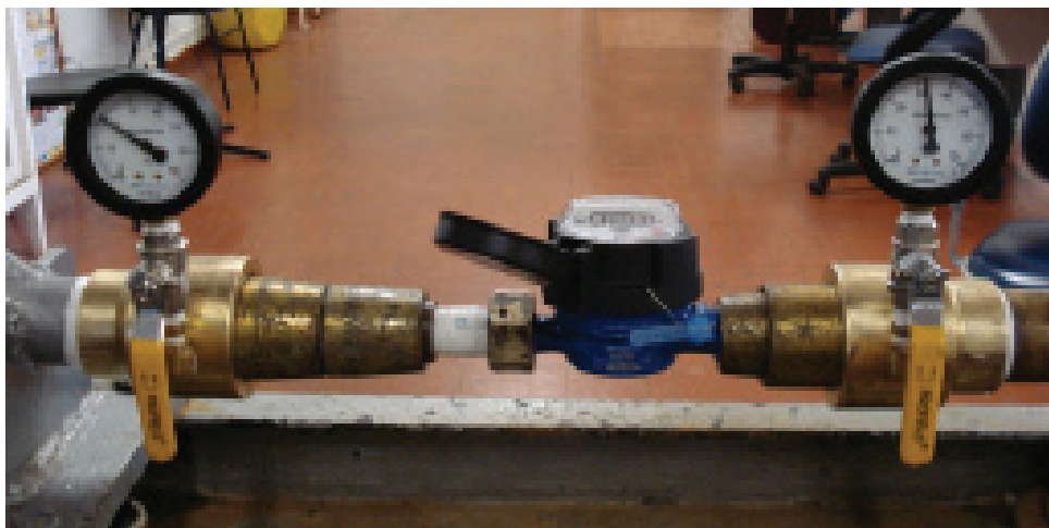
Figura 1 - Bancada do teste com manômetros instalados a montante (32 mca) e a jusante (20 mca) do hidrômetro.
