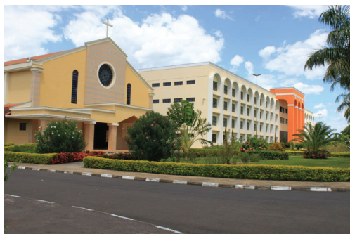
Figura 2: Igreja Universitária, climatizada, com capacidade para 1000 pessoas sentadas.
