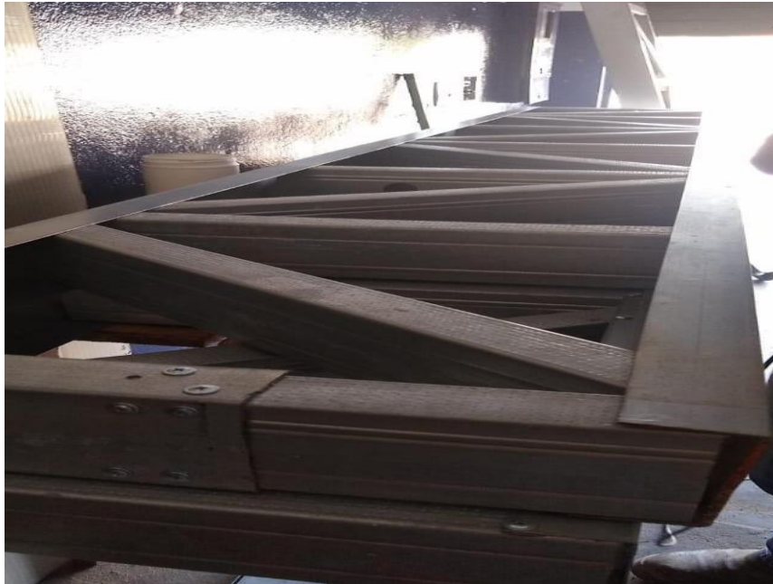
Figura 3: Treliça 1 executada com perfis de Light Steel Frame.
