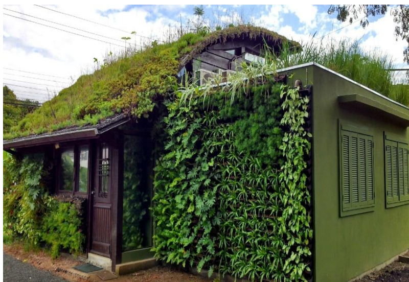
Figura 3 - Telhado verde. Fonte: EcoTelhado (2018).
