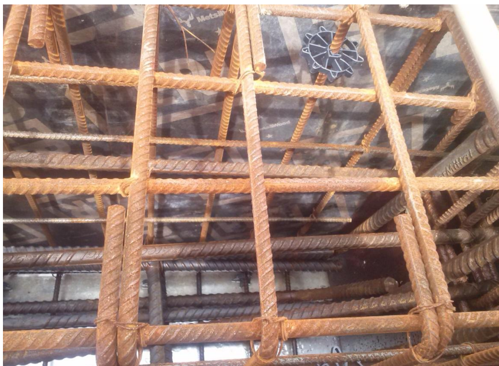
Figura 6 – Verificação do cobrimento de armadura.
