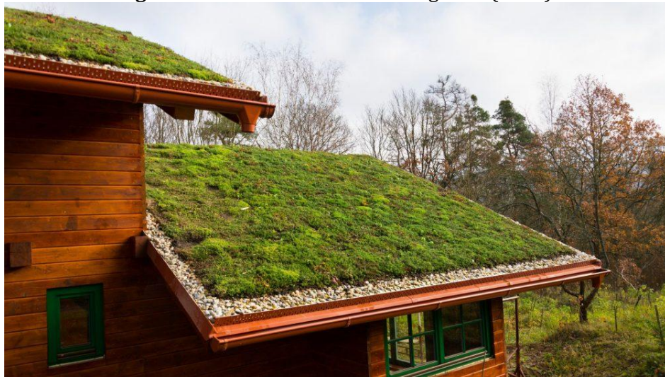
Figura 1 - Telhado verde. Fonte: Bigstock (2018).
