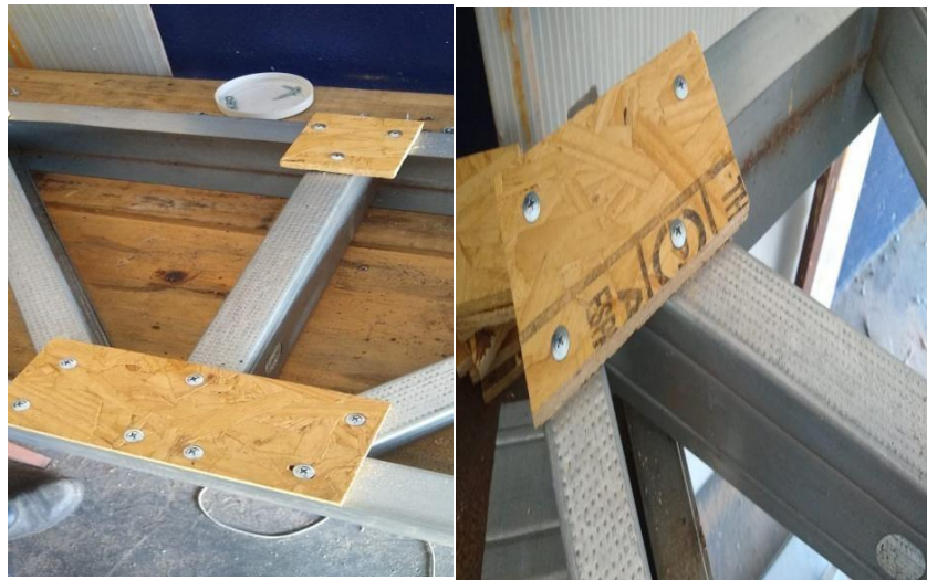
Figura 5 a e b: Disposição das placas OSB na treliça 3.
