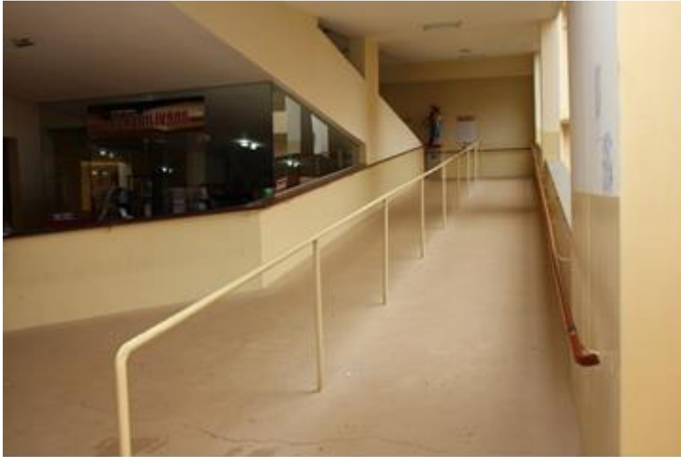
Rampa de acesso ao piso superior
