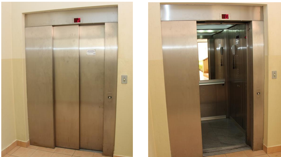
Elevadores de acesso aos pisos superiores
