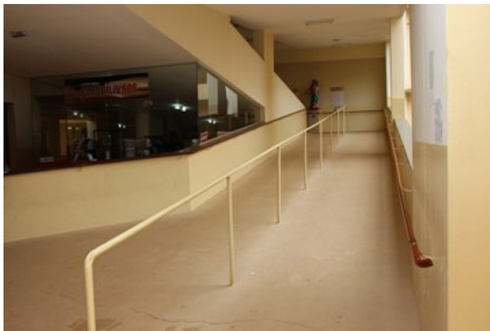
Rampa de acesso ao piso superior
