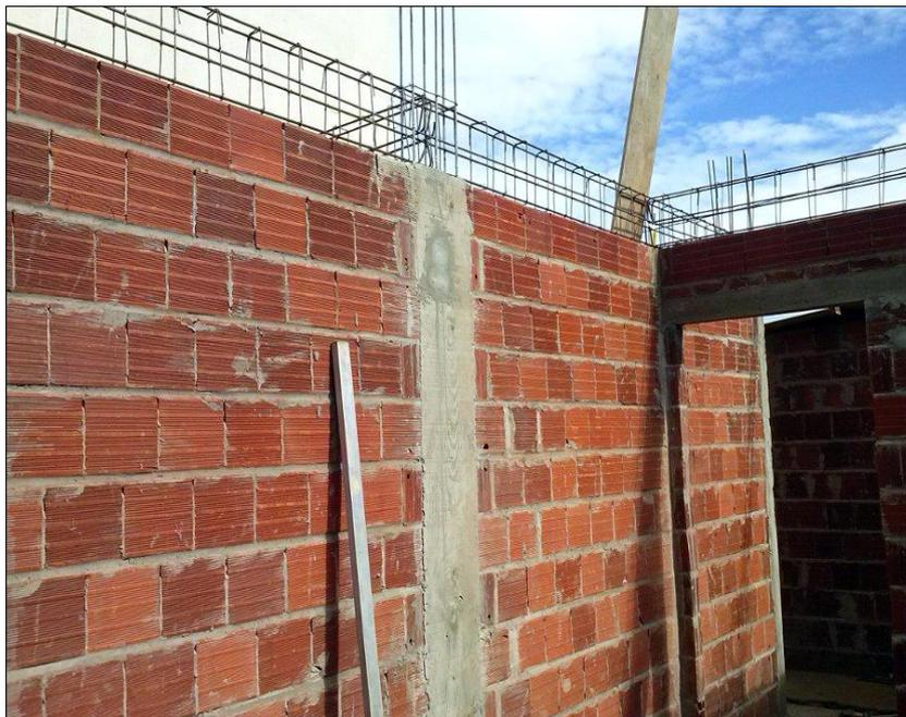
**Figura 2** - Alvenaria construída com argamassa convencional.
