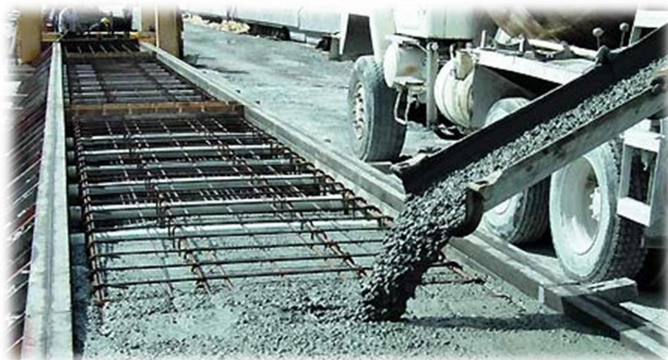
**Figura 1** - Lançamento do concreto autoadensável. Fonte: BASF (2013).
