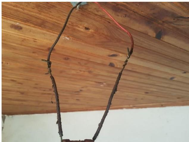
**Figura 8** - Emenda sem isolamento. Fonte: autores.
