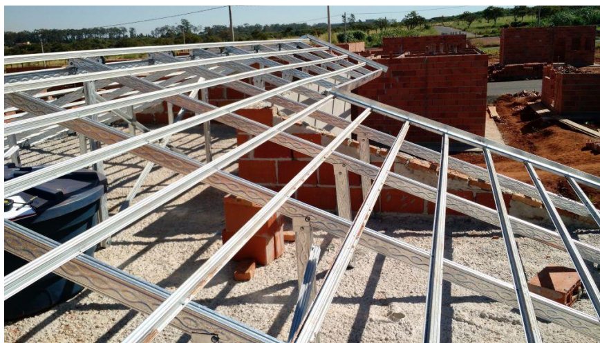
Figura 1 - Telhado com estrutura em aço de acordo com Ecoframe (2018). Fonte: autores.
