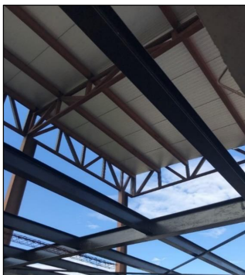
Figura 1. Estrutura metálica. Fonte: autores.
