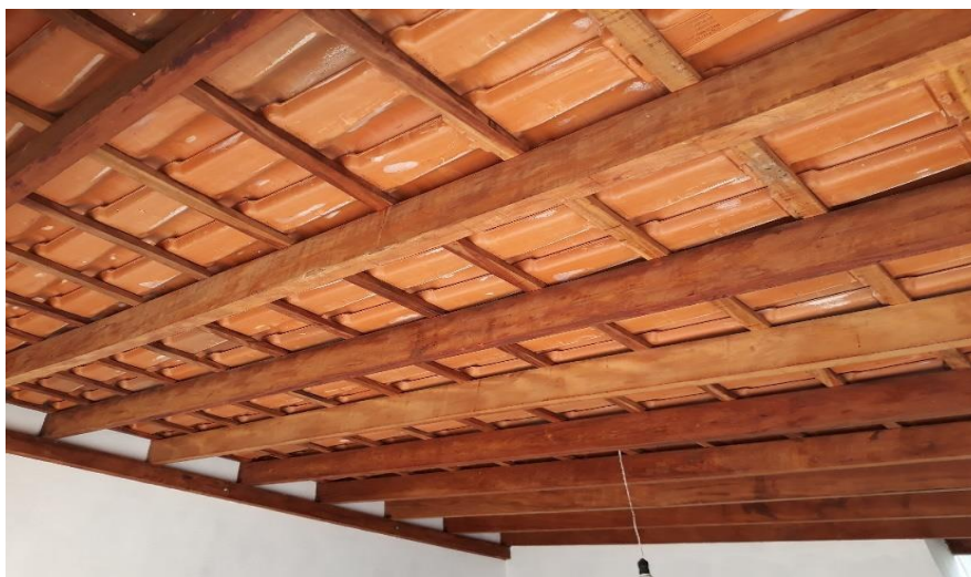
Figura 2 - Telhado com estrutura em madeira convencional. Fonte: autores.
