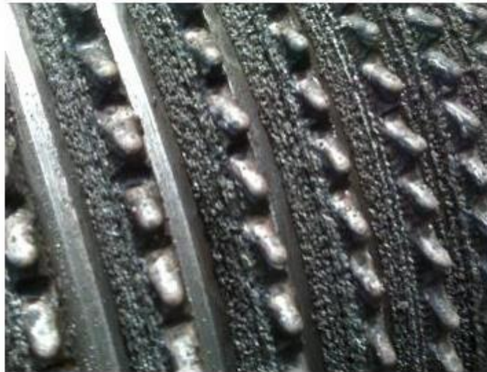
Figura 4 – Chapisco aplicado pelo processo automatizado.
