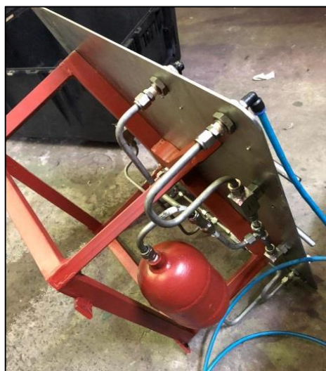
Figura 12 - Limpeza dos fluidos internos dentro das tubulações após o teste de pressão. Fonte: Próprio Autor.
