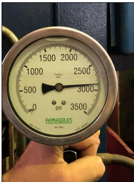
Figura 11 - Manômetro indicando a pressão do teste após a troca da tubulação. Fonte: Próprio Autor.
