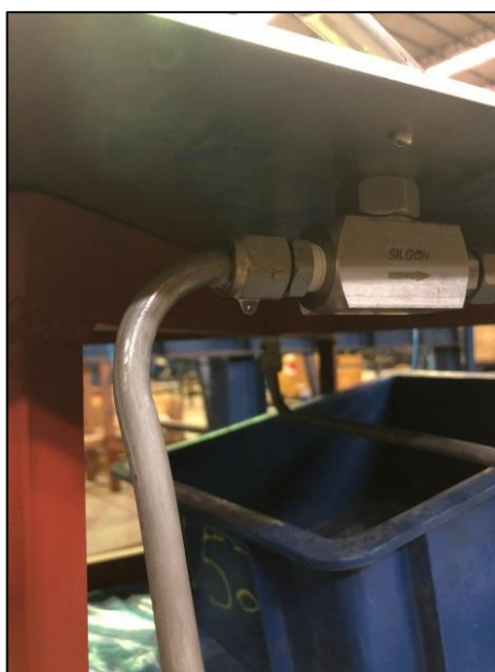
Figura 8 - Conexão apresentando vazamento. Fonte: Próprio Autor.
