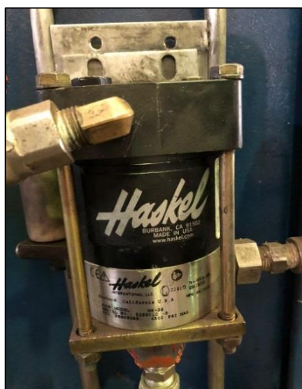
Figura 6 - Bomba Haskel utilizada para a realização do teste de pressão na bancada. Fonte: Próprio Autor.
