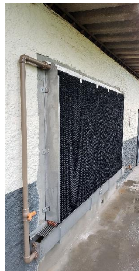
Figura 10 -Instalação de sistema Pad Cooling Fonte: Autores, 2019
