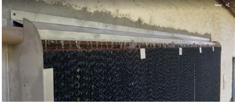
Figura 11 –distribuição uniforme de água nas placas evaporativas Fonte: Autores, 2019
