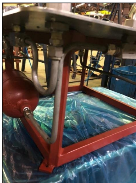
Figura 10 - Tubulação nova com dobra feita mais longe da conexão. Fonte: Próprio Autor.
