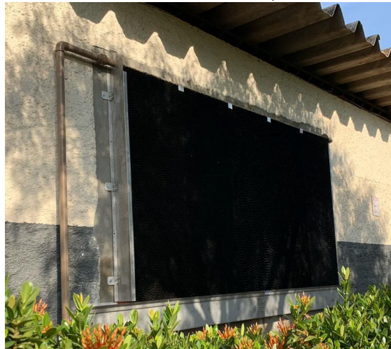
Figura 13 -Instalação de sistema Pad Cooling, interno. Fonte: Autores, 2019
