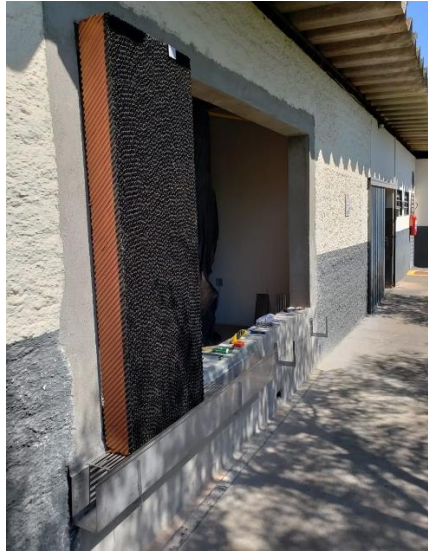
Figura 9 -Instalação de sistema Pad Cooling Fonte: Autores, 2019
