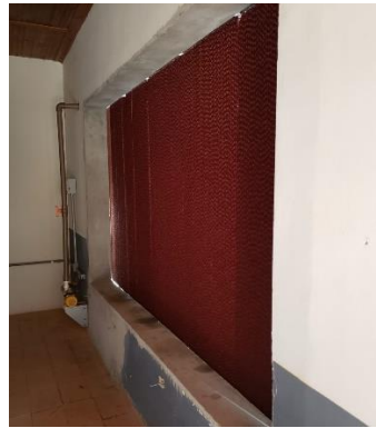
Figura 12 -Instalação de sistema Pad Cooling, interno. Fonte: Autores, 2019
