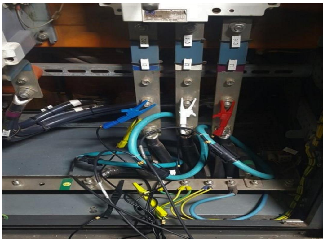
Figura 16 – Conexões de TP's e TC's no barramento de alimentação do módulo regenerativo para medição (Fonte do autor).
