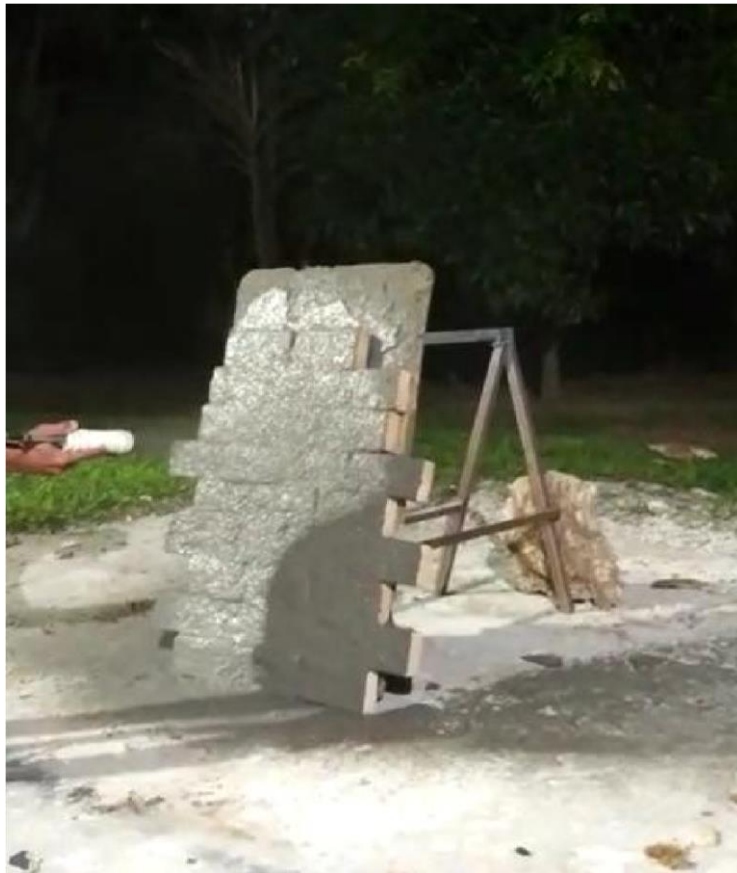
Figura 6 - Teste realizado com chapisco e argamassa . Fonte: Autores.
