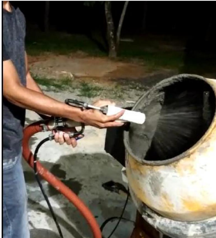
Figura 5 – Ajuste de pressão de trabalho utilizando argamassa. Fonte: Autores.
