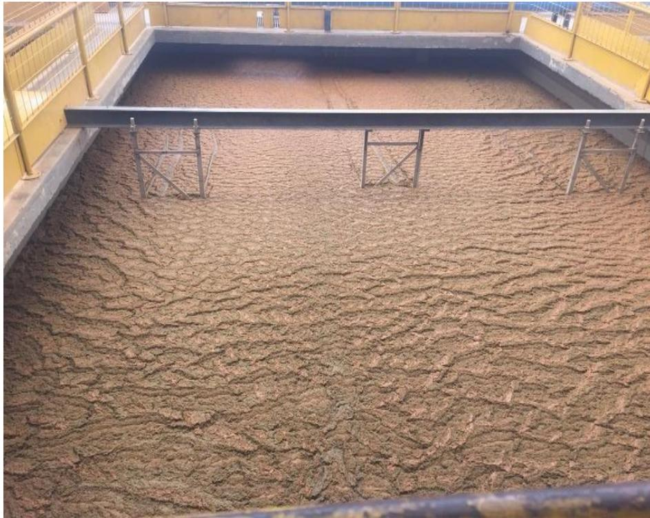
Figura 01: Produção de lodo no processo de floculação
