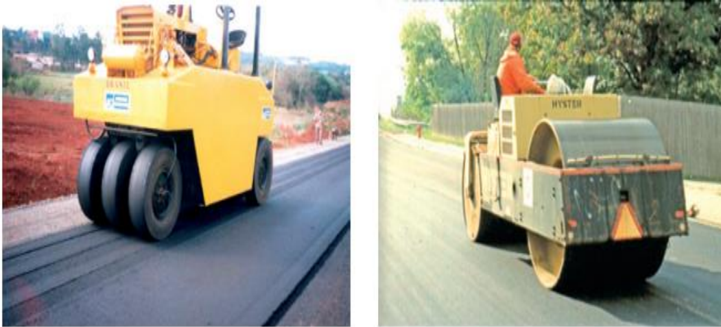
Figura 16: Rolo de pneus e rolo tandem liso. Fonte: (Bernucci, 2008)
