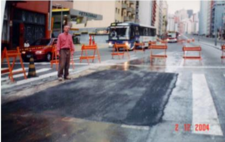
Figura 09: Remendo na Avenida Nove de Julho – São Paulo/SP. Fonte: (SOUZA, 2004).
