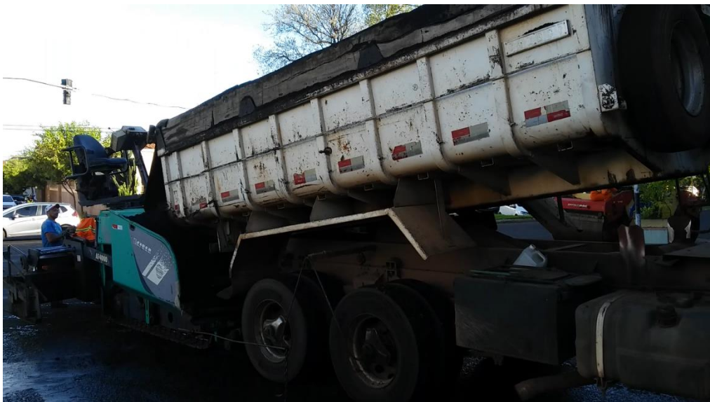
Figura 23: Caminhão basculante lançando massa asfáltica. Fonte: autores.
