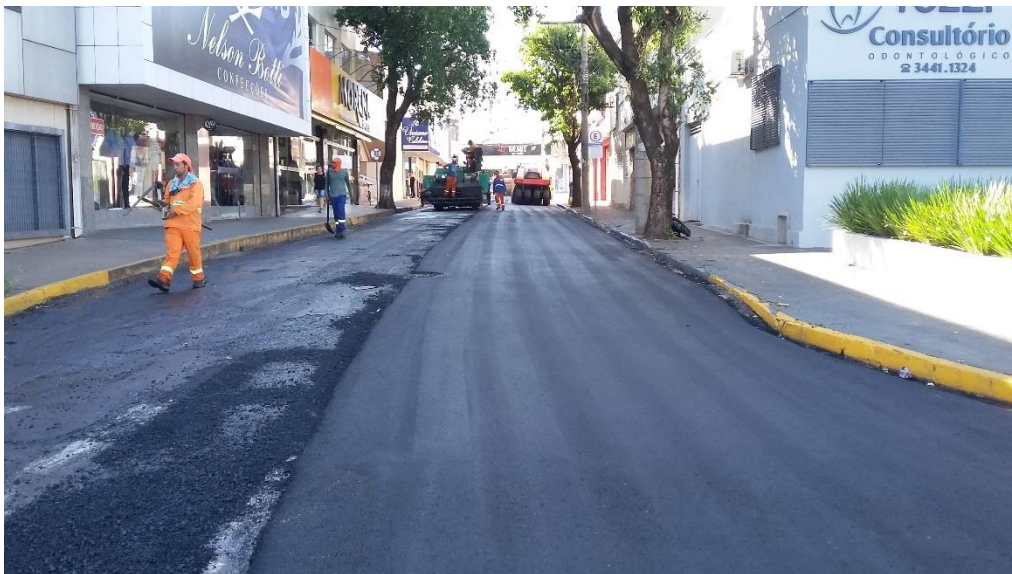
Figura 27: Serviço parcialmente concluído. Fonte: autores.
