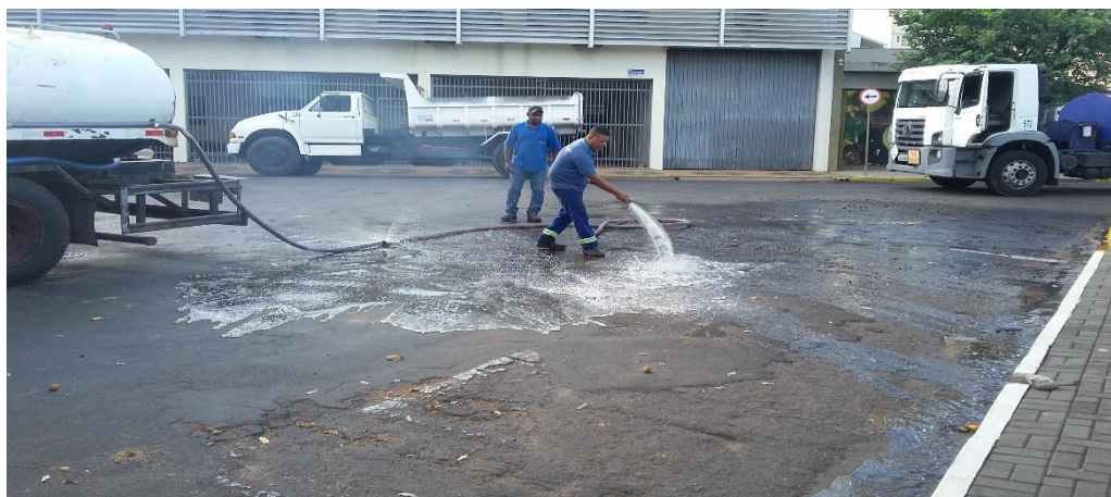
Figura 14: Umedecimento de local para aplicação de ligante. Fonte: autores.
