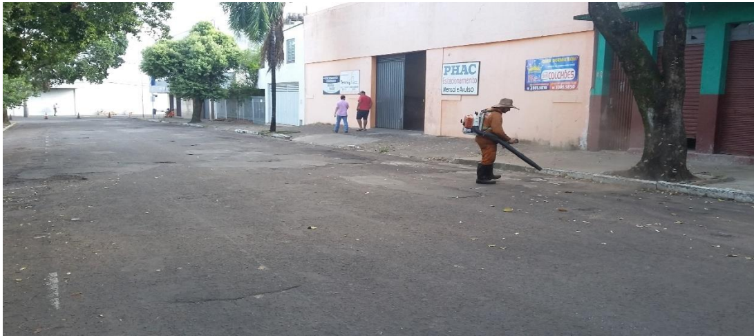
Figura 20: Limpeza da via pública para receber recapeamento. Fonte: autores.
