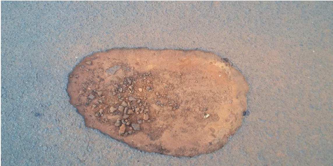
Figura 04: Exemplo de revestimento asfáltico onde a solução é o tapa-buraco.
