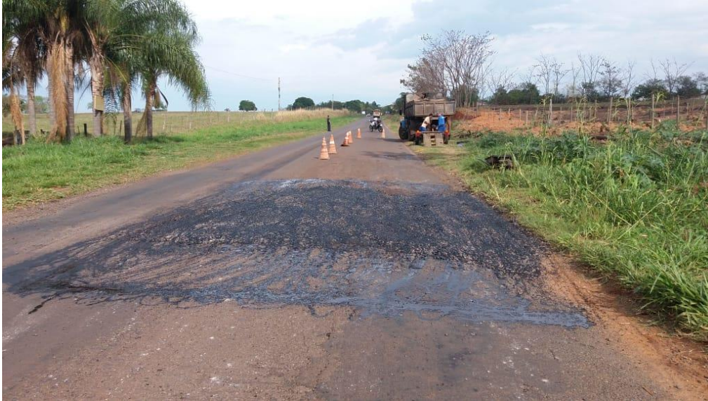
Figura 30: Local preparado para lançamento da massa asfáltica, sem recorte.
