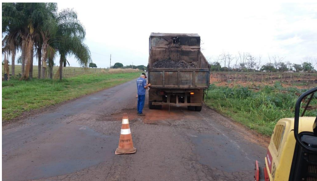
Figura 29: Local da operação tapa-buraco com impurezas. Fonte: autores.
