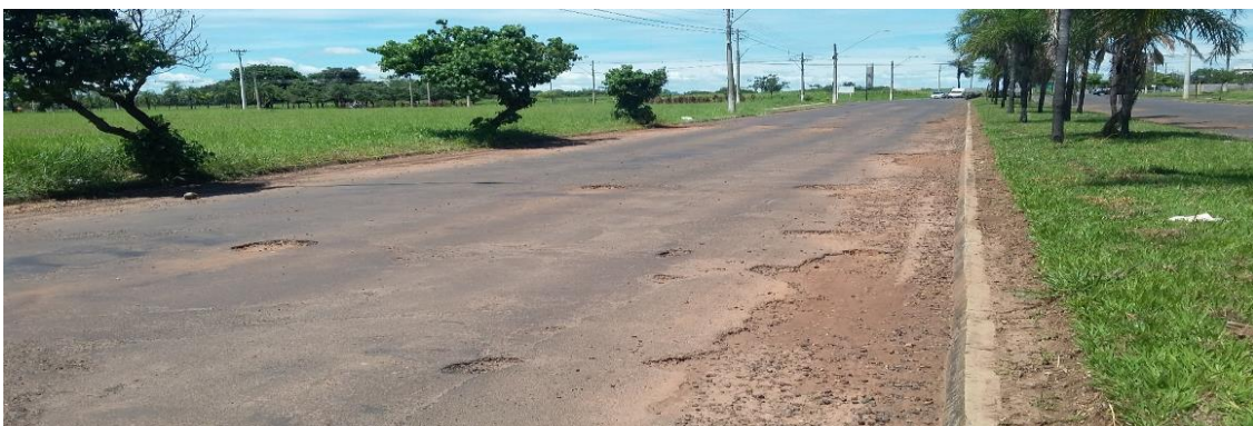
Figura 01: Buracos encontrados em trecho da Avenida José Teles de Menezes, Araçatuba - SP. Fonte: autores.
