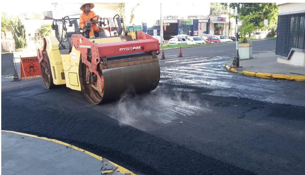
Figura 25: Compactação feita com rolo liso. Fonte: autores.
