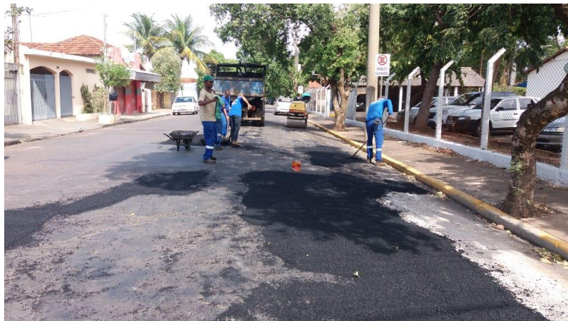
Figura 15: Espalhamento de massa com utilização de rastelos. Fonte: autores.
