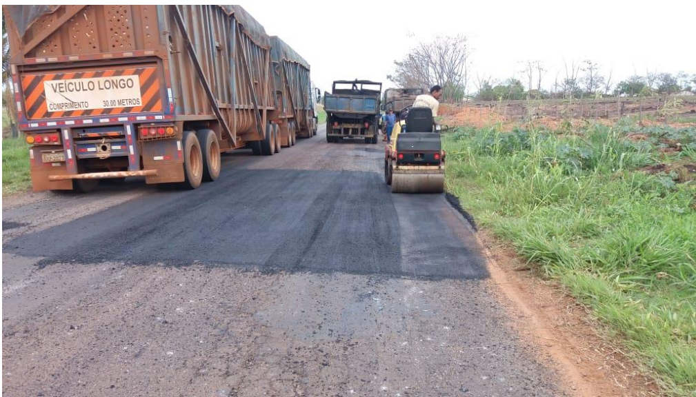
Figura 31: Utilização de mini rolo compactador e serviço finalizado. Fonte: autores.
