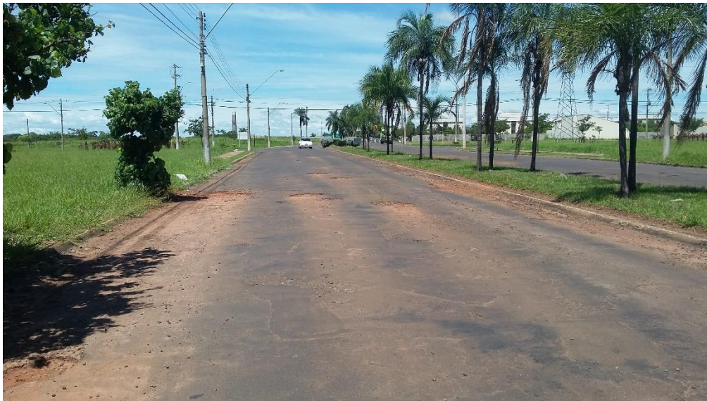
Figura 19: Revestimento asfáltico bem degradado. Fonte: autores.
