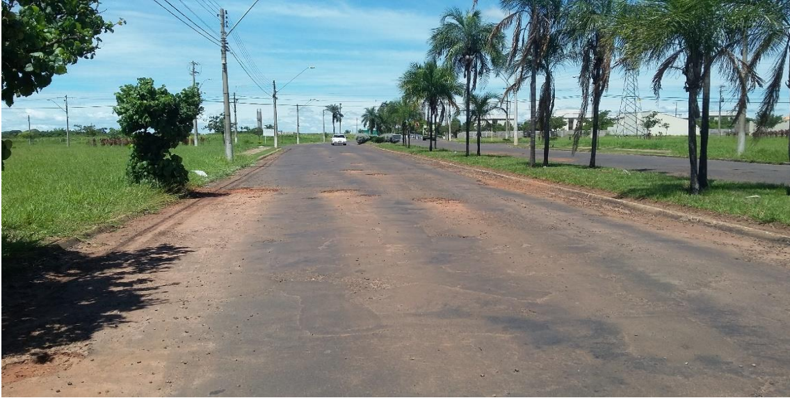
Figura 02: Buracos encontrados na Avenida José Teles de Menezes, Araçatuba-SP.
