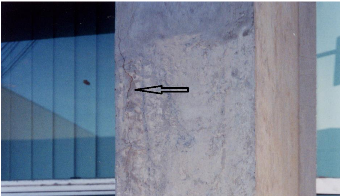
Figura 05 – Pilar Fissurado. Fonte: autores.
