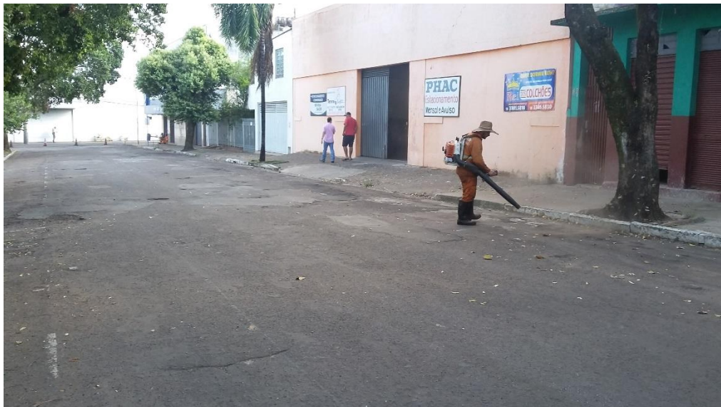
Figura 13: Limpeza do local. Fonte: autores.
