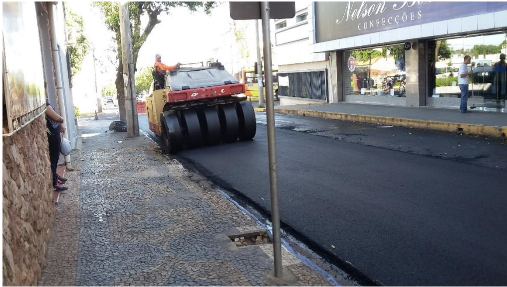
Figura 26: Rolo compactador com pneus. Fonte: autores.
