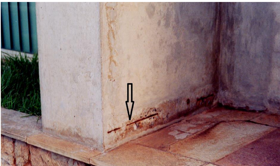
Figura 03 – Pilar com estribo Exposto (I). Fonte: autores.
