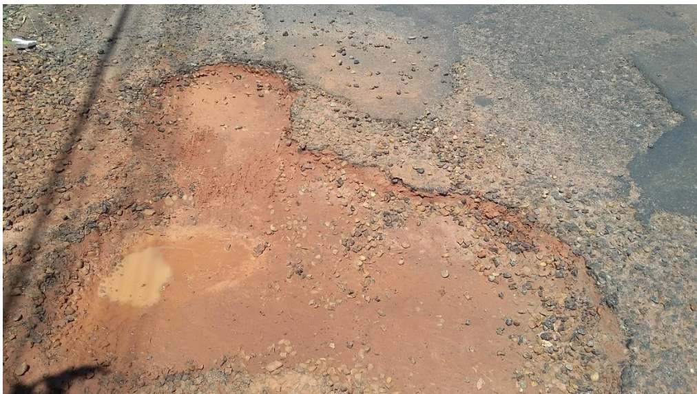
Figura 18: Revestimento degradado até o subleito. Fonte: autores.
