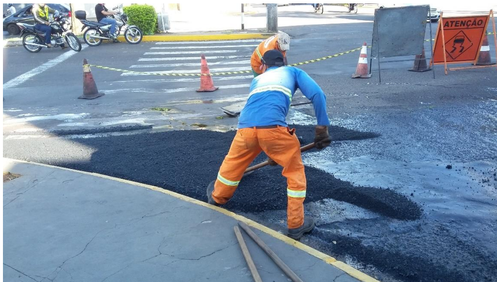
Figura 24: Trabalhadores espalhando massa asfáltica. Fonte: autores.
