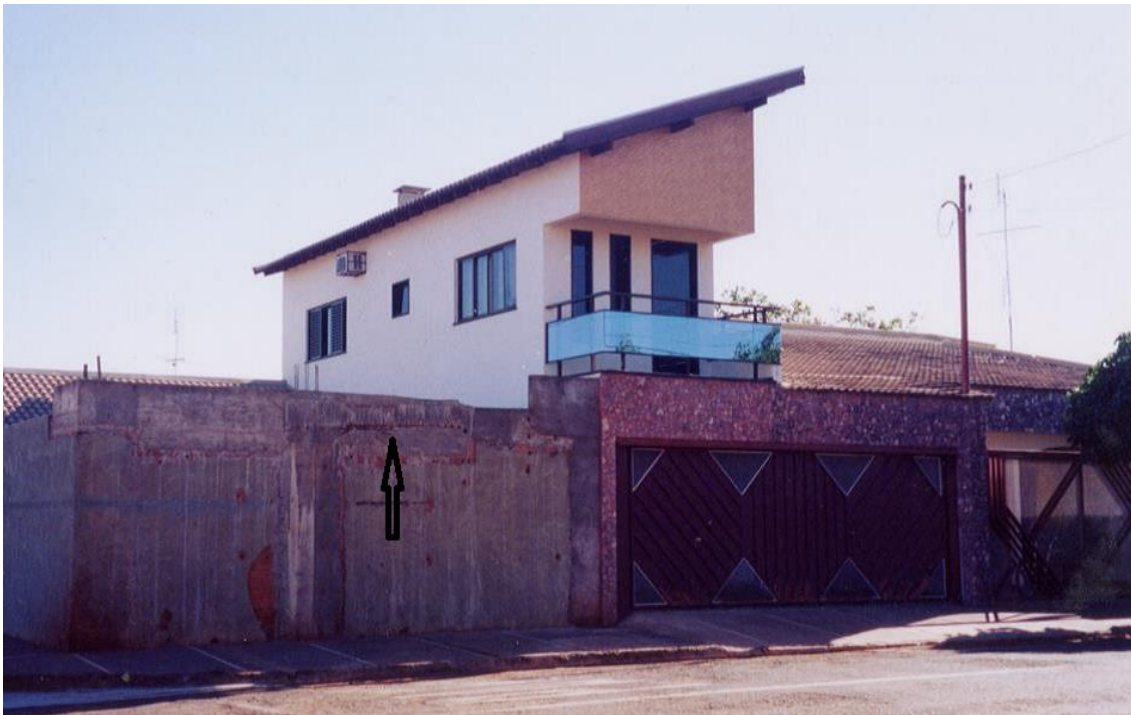
Figura 06 – Armadura exposta vista de longe. Fonte: autores.
