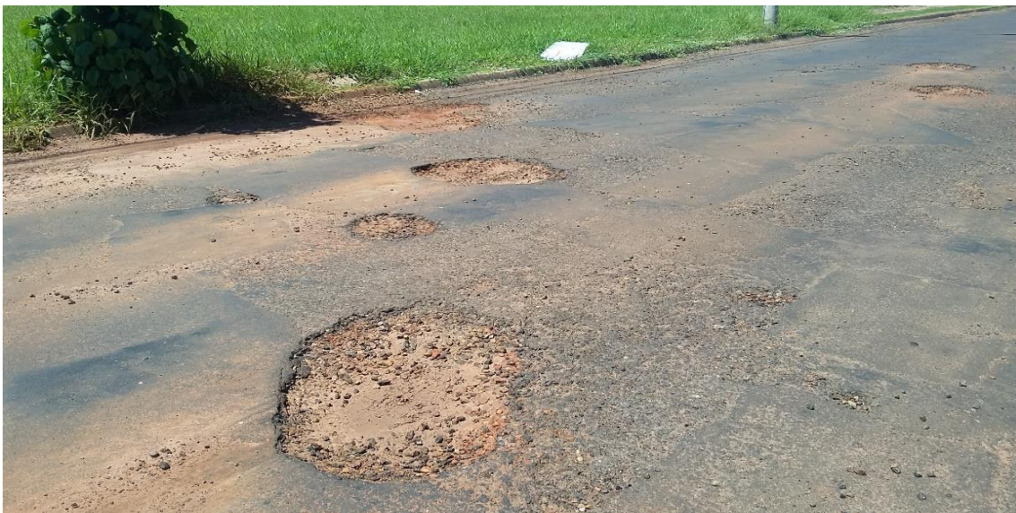
Figura 03: Exemplo de revestimento asfáltico onde a solução é o recapeamento.
