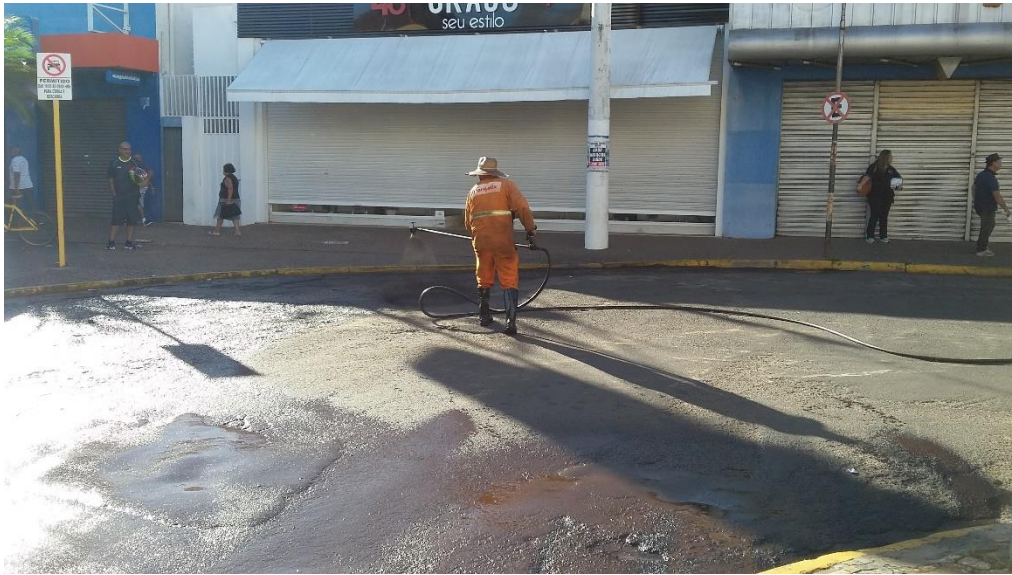
Figura 22: Imprimação da via com espargidor manual. Fonte: autores.
