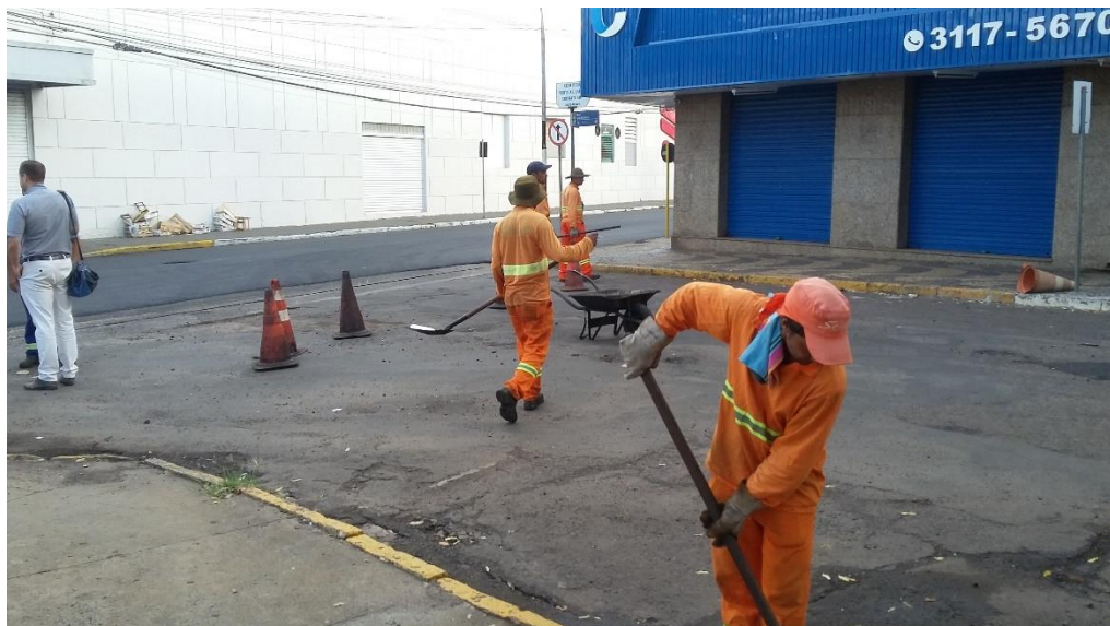
Figura 21: Limpeza da via feita manualmente. Fonte: autores.
