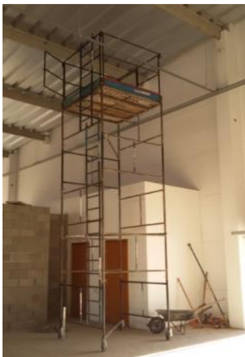
Figura 3 - Andaime finalizado. Fonte: autores.
