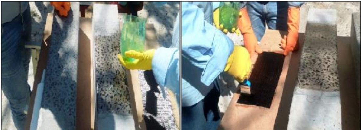
Figura 9 – Aplicação sobre a superfície do elemento e no tecido. Fonte: autores.
