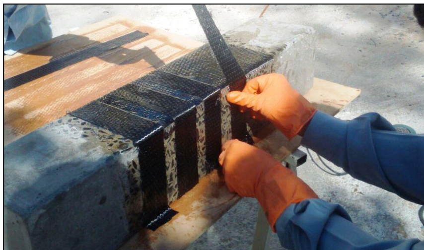
Figura 12 – Realização da ancoragem com tiras. Fonte: autores.
