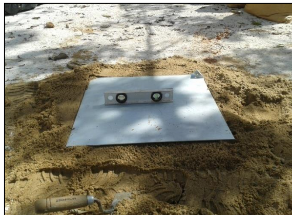
Figura 3 – Nivelamento da base. Fonte: autores.
